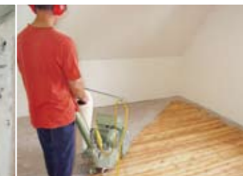
Der alte Holzboden im Obergeschoss wurde erhalten, drei Mal geschliffen und versiegelt.
