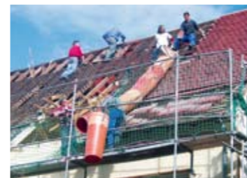
Die Dacheindeckung musste weg, um Zwischen- und Aufsparrendämmung verlegen zu können.
